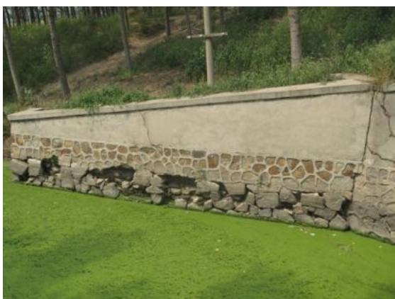
图 14 背水面翼墙砌石松动
