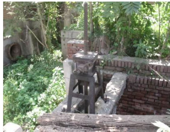
图 8 扶头水站闸自流道启闭机老化、锈蚀
