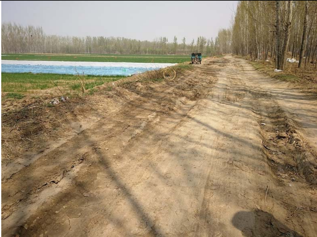
图 4 北京排污河左堤堤顶现状 4（堤顶土路）
