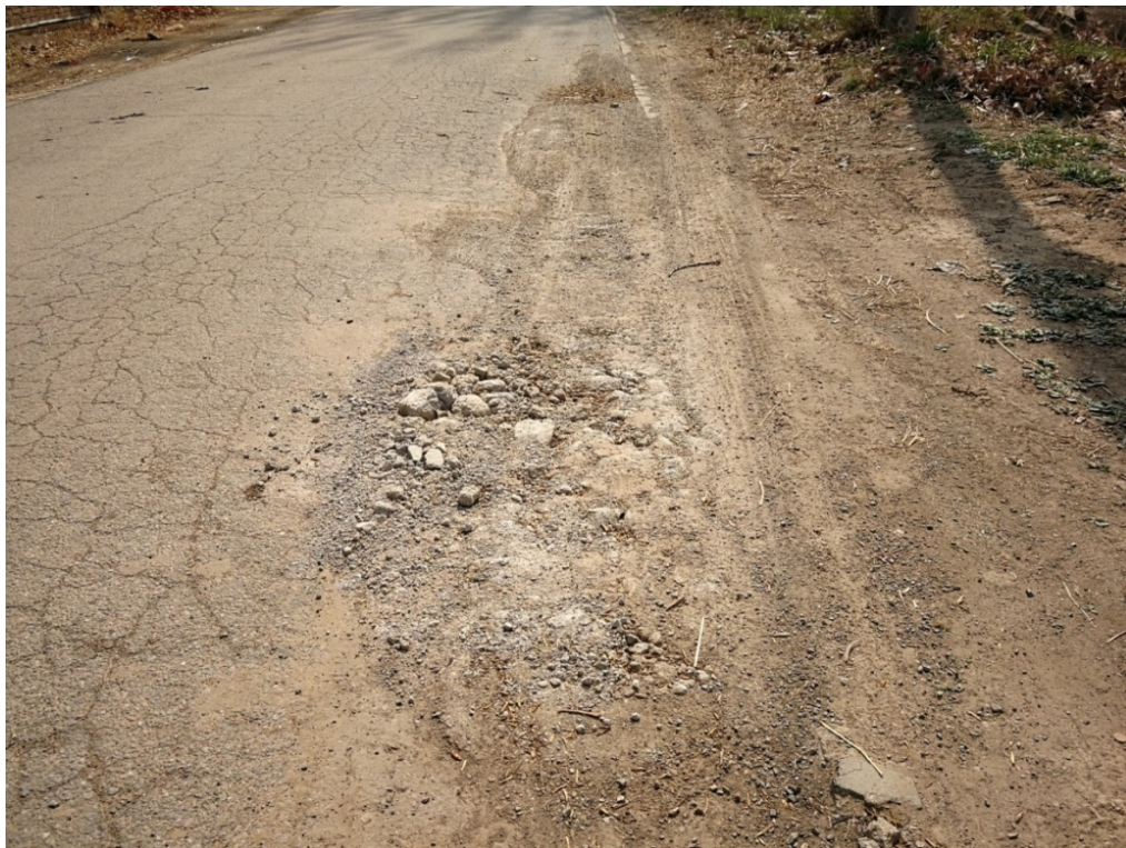
图 3 北京排污河左堤堤顶现状 3（沥青路面）
