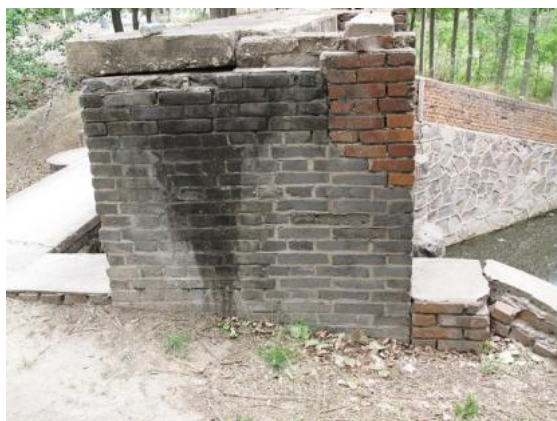
图 12 牛镇水站自排闸启闭机柱砌砖粉化
