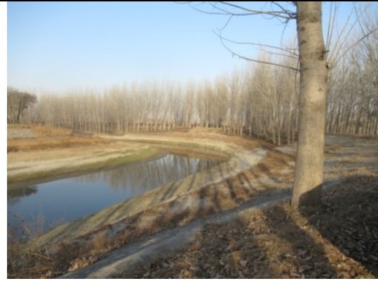
右堤植被现状 02
