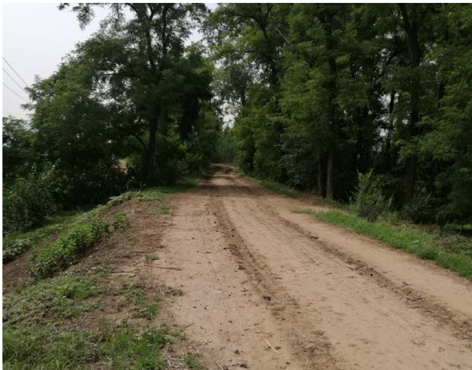
图 6 北京排污河右堤堤顶现状 2（高王公路下游段）
