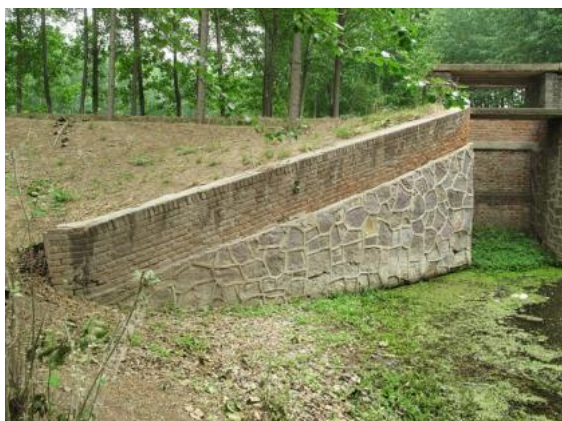
图 11 牛镇水站自排闸迎水面翼墙现状
