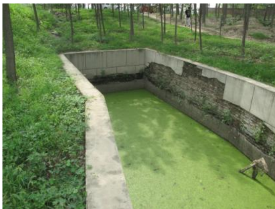
图 7 扶头水站闸迎水面右侧护坡破损
