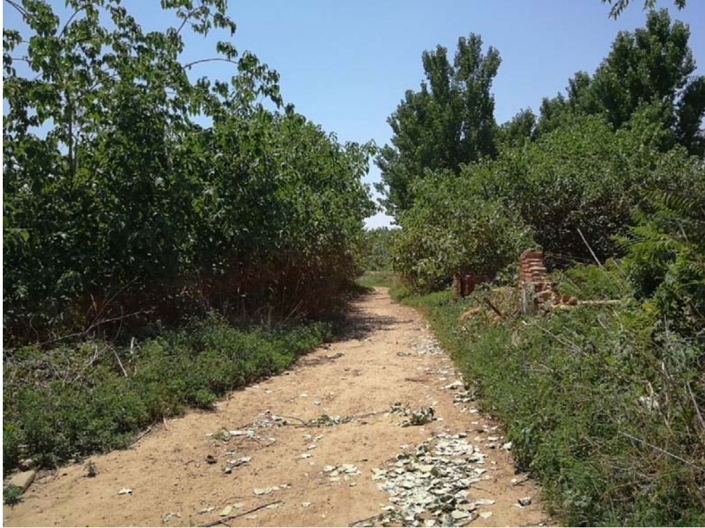
图 1 北京排污河左堤堤顶现状 1
