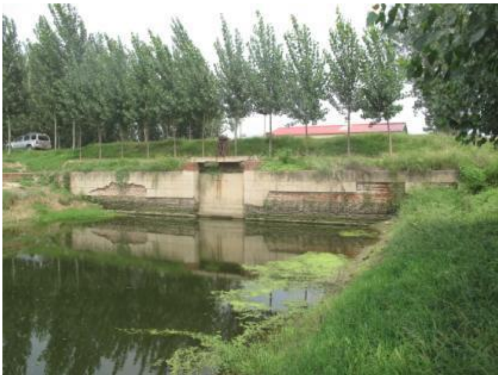
图 17 亭上水站闸现状
