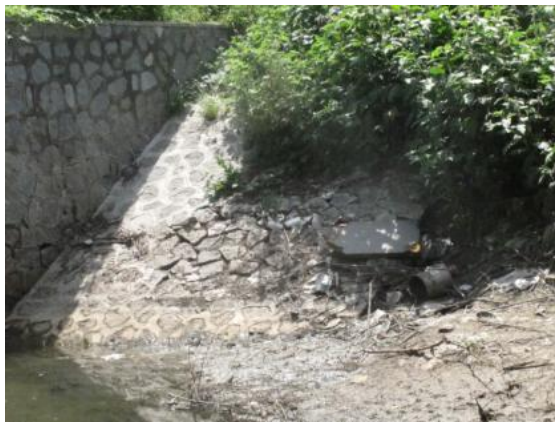
图 7 扶头水站闸迎水面右侧护坡破损
