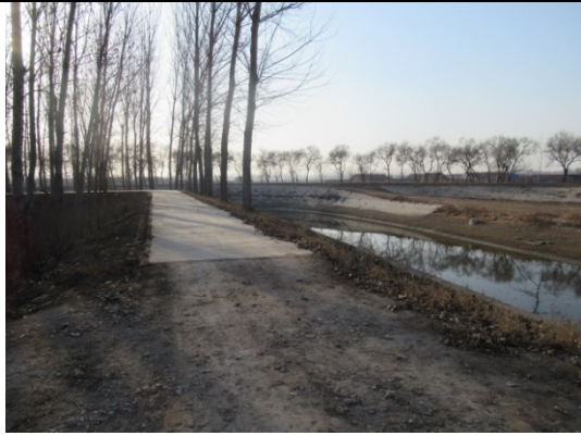
右堤植被现状 01
