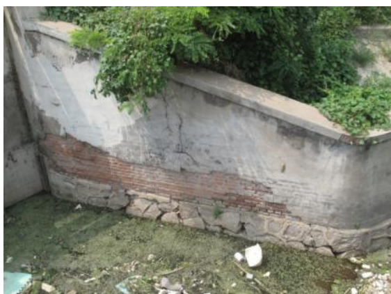
图 13 迎水面翼墙图
