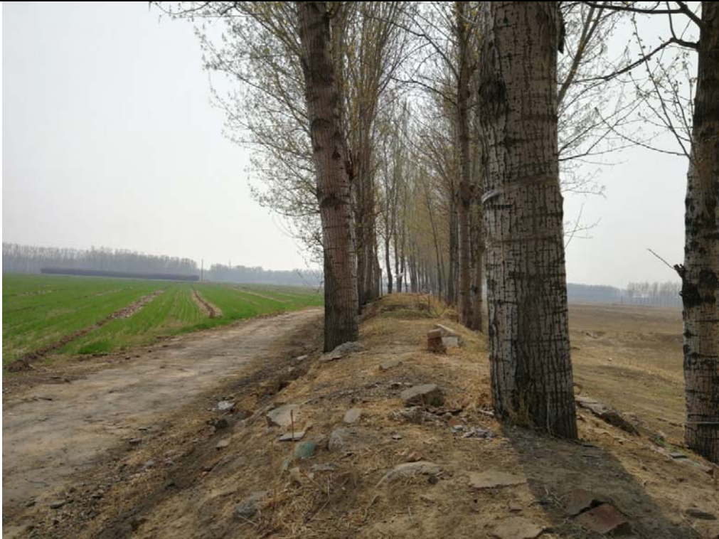
图 5 北京排污河右堤堤顶现状 1（高王公路上游段）
