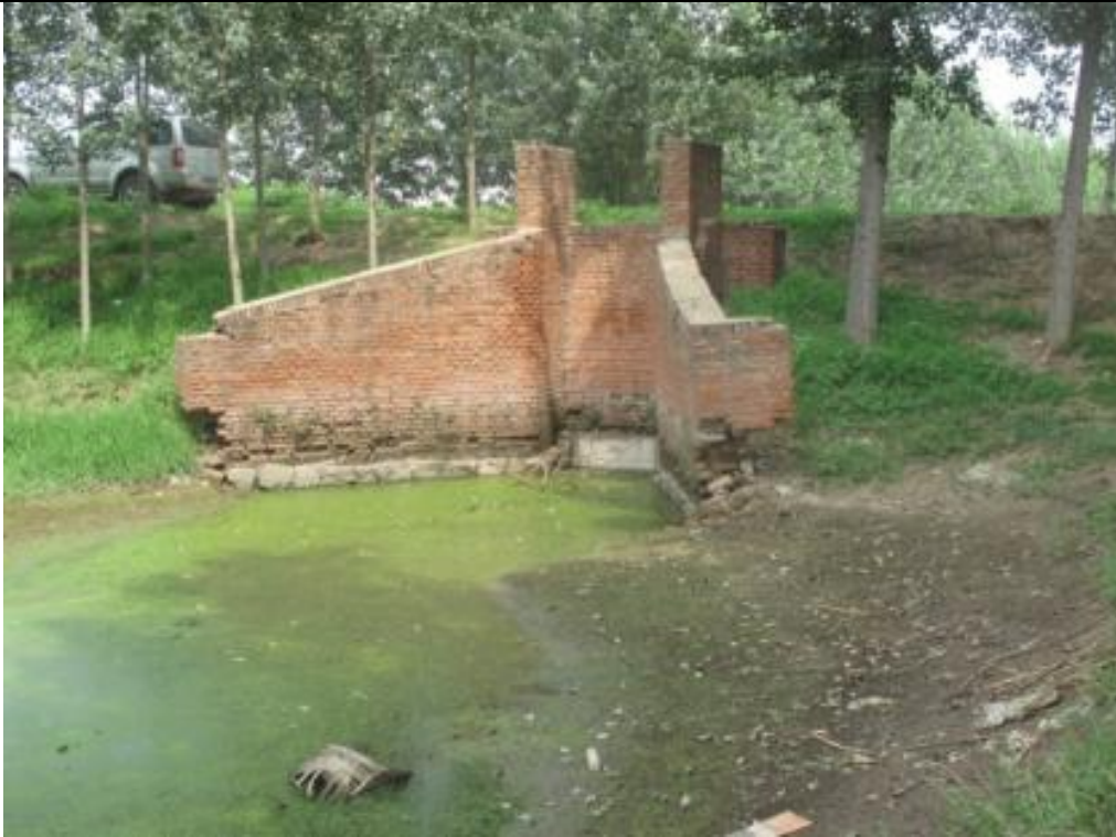
图 16 小押虎寨涵闸现状
